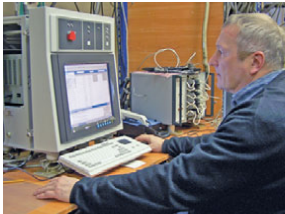
Настройка автоматизированного комплекса связи на испытательном стенде ЗАО «ПКБ «РИО»
