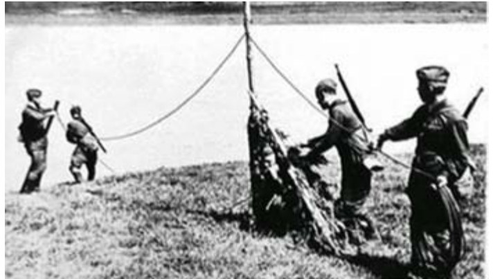
Прокладка линии связи через реку
